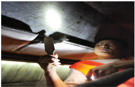
杨师傅为桥下破损裸露的钢筋去除锈迹
