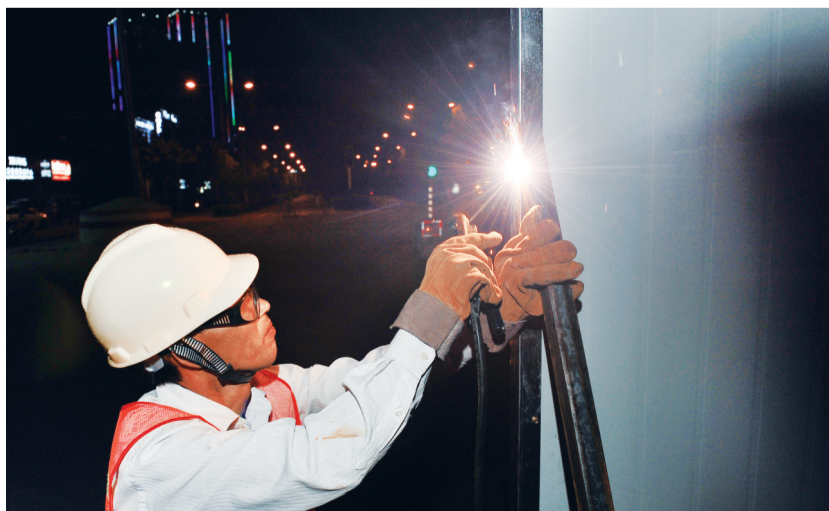
昨晚11时,望江路与岳西路交口,施工人员在架设围挡
