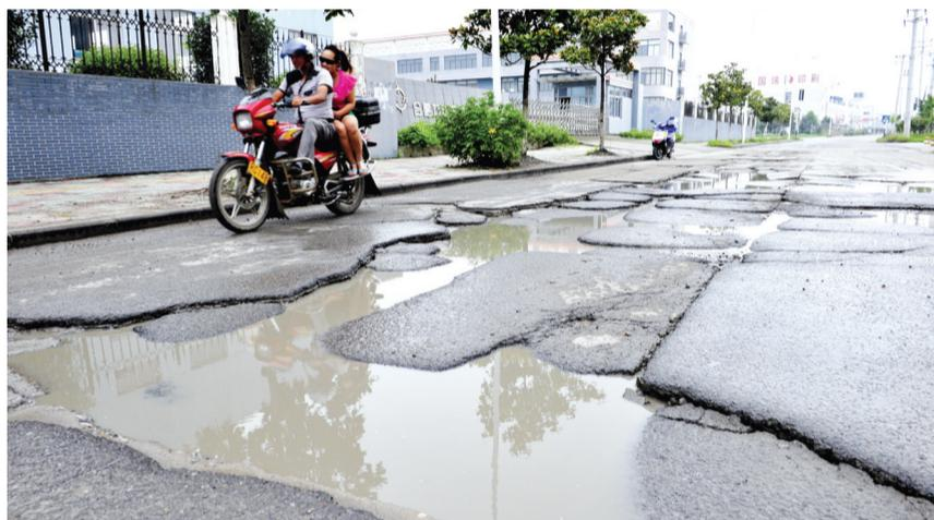
合肥市金池路车流量大,经过长时间的磨损,多处路面出现破损、断裂、沉陷和坑洞等现象。昨日记者获悉,该路近期将启动改造,改造工程南起官塘路、北至汲桥路,全长1500米,总投资2000万元。
