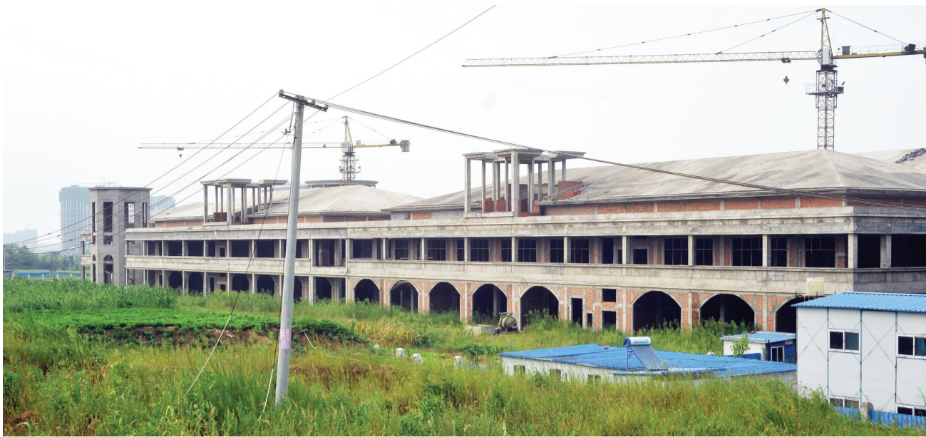
整个工程已停工
