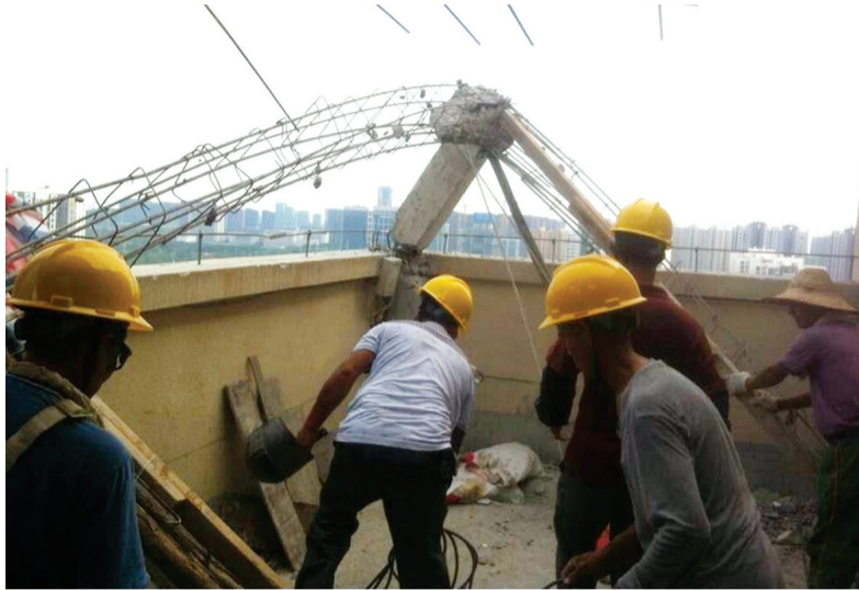
工人现场拆除
