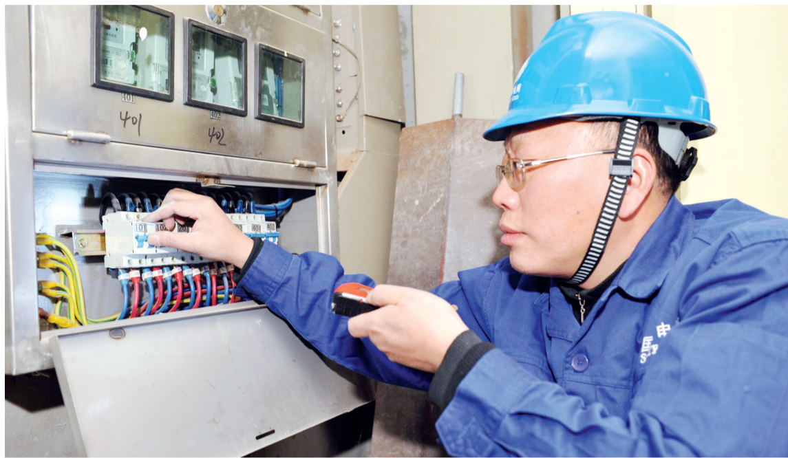
供电员工上门为居民提供维修服务
