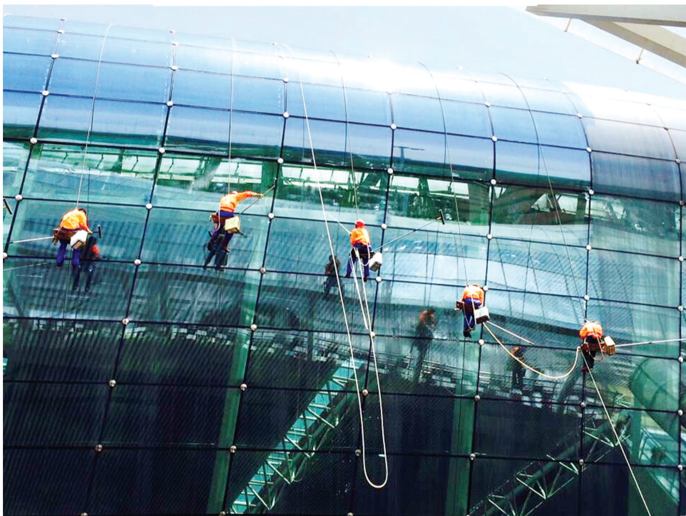
合肥新桥国际机场航站楼因独特的造型被人们美誉为“热带鱼”。日前,深圳一家保洁公司十多名“蜘蛛人”接手了清洗任务,运用多种清洗工具,花了近一个月时间,到6月初,终于完成 6.5 万平方米航站楼幕墙清洗。这也是“热带鱼”的第一次“洗脸”。 方明阳 记者 祝亮 文/图
