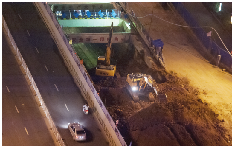
挖掘机正在“卖力”干活
