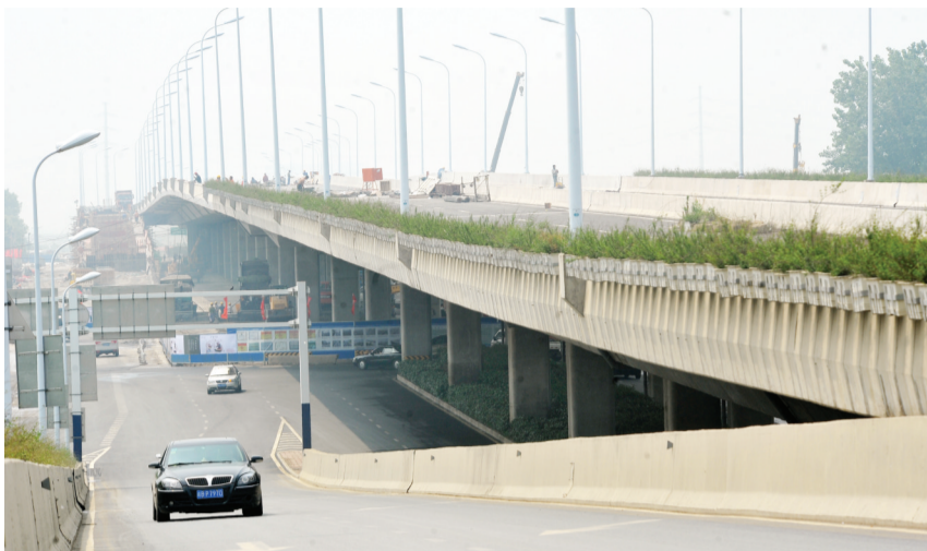
施工中的二标段
