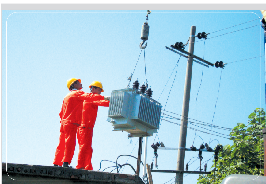
沈村供电营业部为上胡村民组更换变压器一台,50千伏安更换为100千伏安
