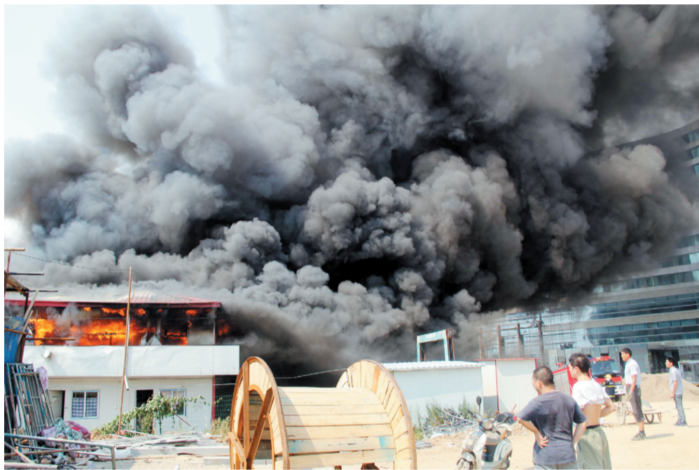
7月31日14时30分许,芜湖市信德华府大酒店建筑工地内多间工人住宿板房起火,大量黑色浓烟滚滚冒出。当地公安、消防等部门接警后,立即紧急出动前往救援。在四五十度的高温炙烤下,部分消防官兵甚至发生了脱水、中暑现象。经过一个多小时的灭火救援,火势被完全扑灭,未造成人员伤亡。 王庆辉 记者 王小雨 李青松 文/图
