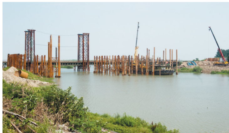
环巢湖旅游大道上的派河大桥已进入桥上施工阶段。 记者 黄洋洋/图
