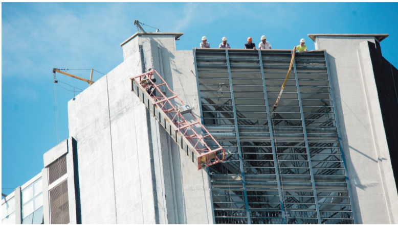
大幅度倾斜的吊篮
