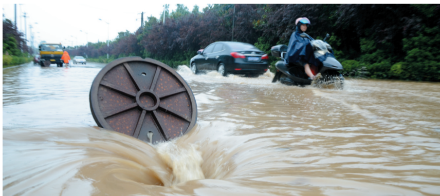
合肥·科学大道一窨井盖被掀开放水。 吴晶 李超钰/图
