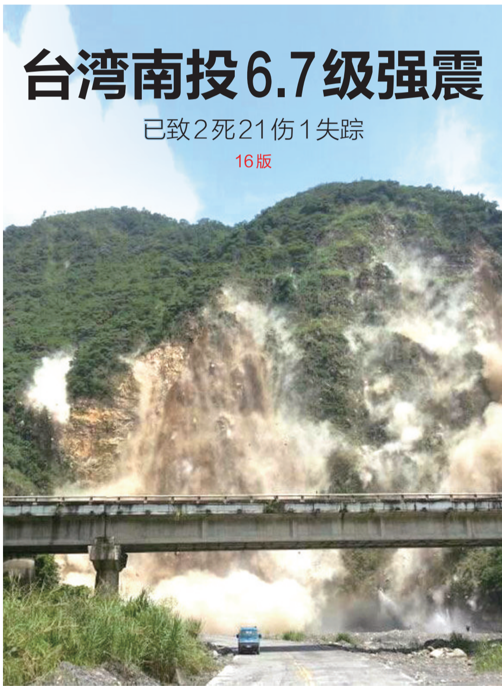
图为南投山区发生崩塌的画面
