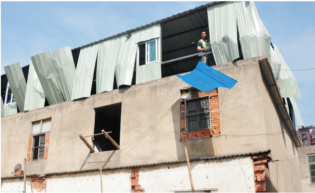
日前,合肥市庐阳区四里河街道联合城管局等多个支队对位于北二环城中村违章搭建进行集中整治。据了解,当日庐阳区桃花片区启动拆迁登记丈量工作,此次拆除违章建设多属于居民房屋顶层加盖的全封闭式简易“隔夜房”,存在极大的安全隐患。康旭 记者程兆 文/图
