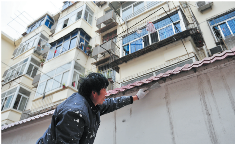
3月26日,合肥市瑶海区窑湾村生活区改造现场,工人正在对围墙进行最后的粉刷。据了解,此次老旧小区改造除了对路面和墙壁进行重新规整和粉刷外,健身器材也将在小区广场中安置。 记者 程兆文/图
