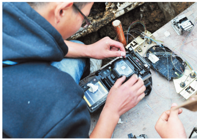
工作人员对光缆进行维修
