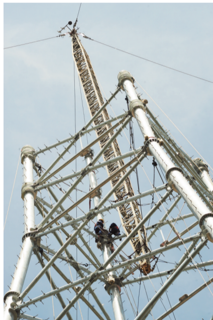
建设中的基杆塔
