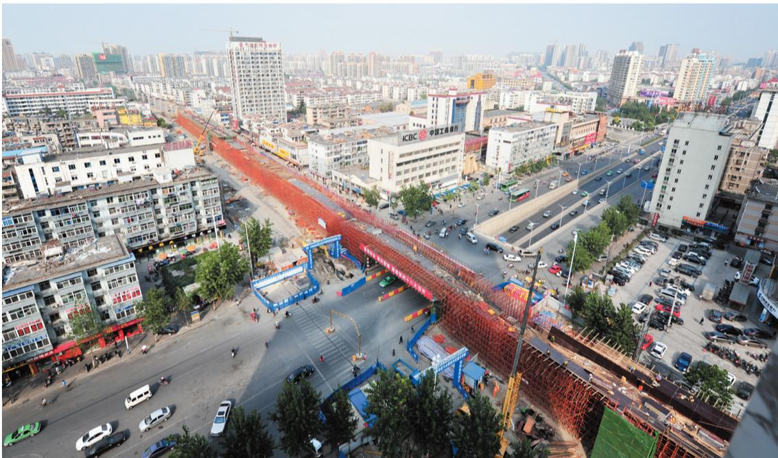
昨日记者在合肥市阜阳路高架桥建设现场看到，该高架南段已经进入空中施工阶段。特别是在北一环节点上，完成了对该道路的“跨越”。据施工单位中铁四局相关负责人介绍，该高架市区起始段桩基已经基本完成。该负责人同时也希望借本报呼吁，超高车辆不要由北一环与阜阳路交口通过，否则会对在建高架带来碰撞的安全隐患。记者 徐涛/文 程兆/图
