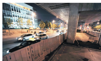
封闭路口旁的高架桥
