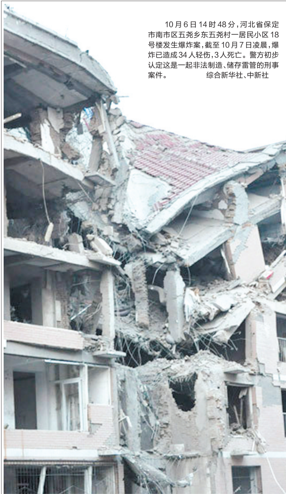
事发楼房从地下室到6层被炸裂
