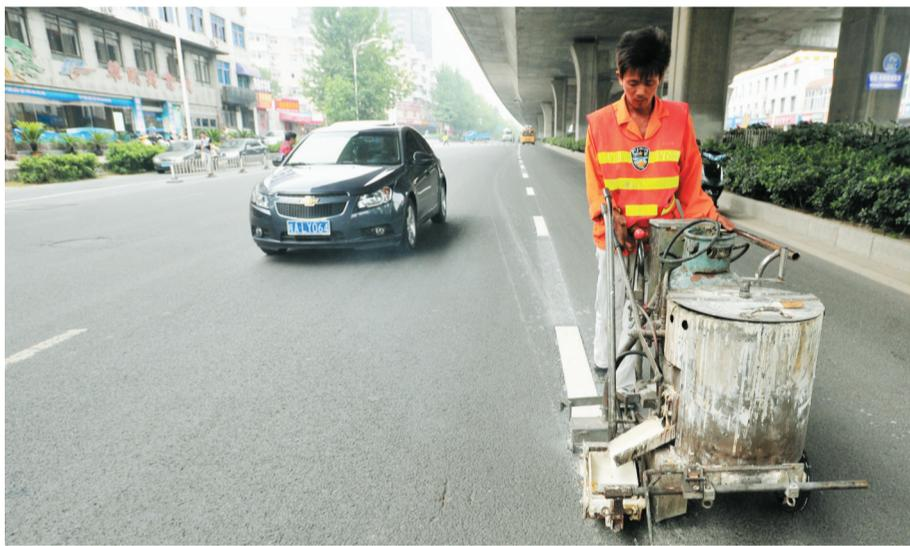
9月6日,合肥市金寨路高架桥下,施工人员正在对地面道路标线重新施划。据悉,本次施工将对南一环至石门路之间金寨路桥上桥下全面施划,施划后的道路将增加对车辆行驶安全的参照标识。
