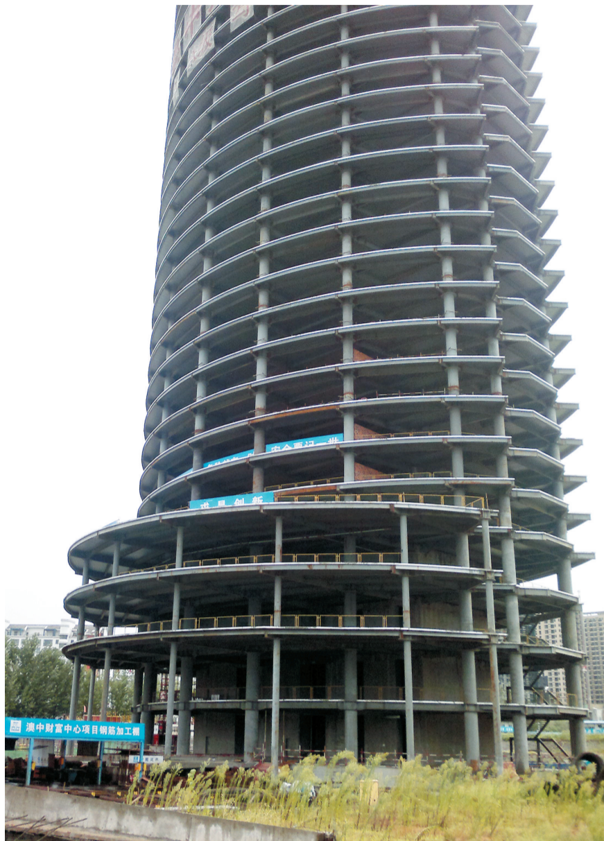
“裸露”的大楼主体建筑
