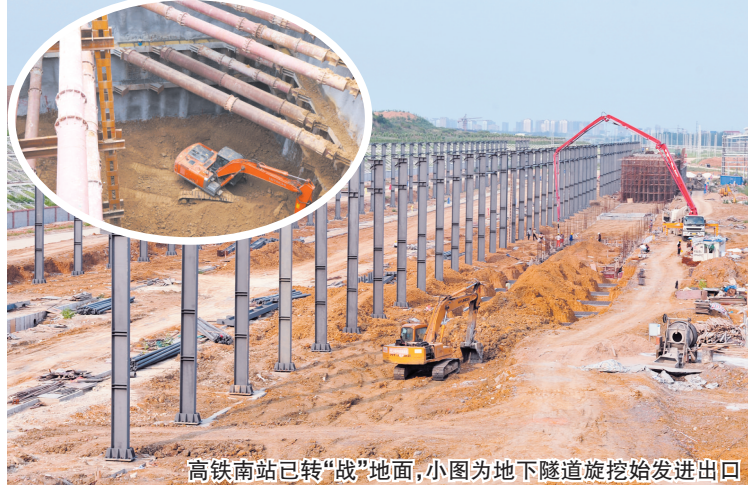
高铁南站已转“战”地面,小图为地下隧道旋挖始发进出口
