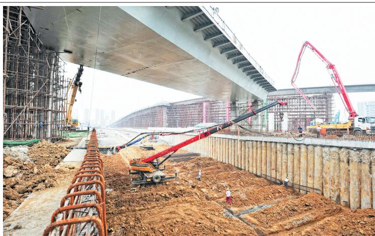
5月30日,合肥市南二环下穿徽州大道高架主体成型,下穿桥的围护桩也已完成,现场施工人员正在全力对下穿道路进行开挖,高铁南站与主城区的无缝衔接渐行渐近。
