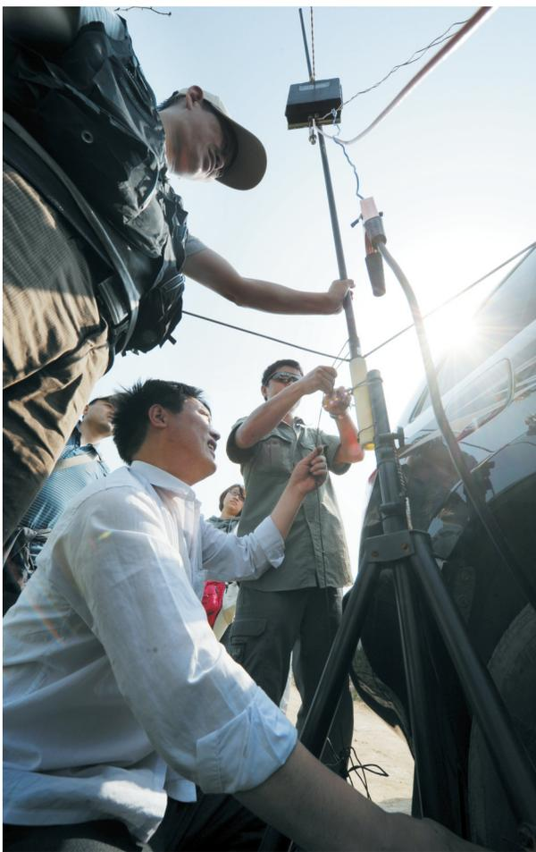
利用材料架设应急通讯电台天线
