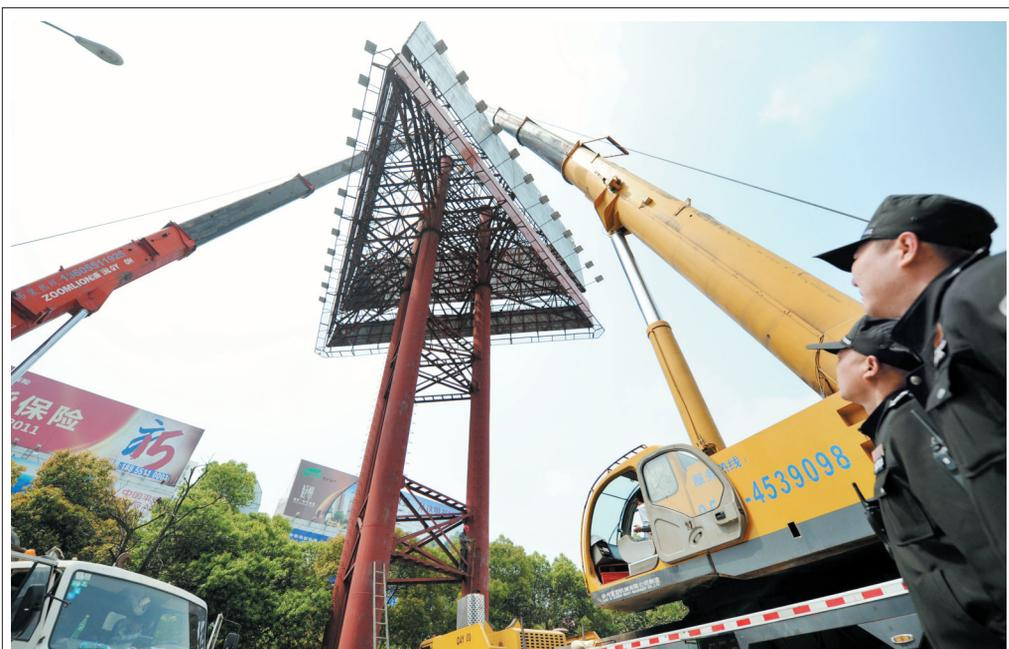
昨日上午，位于合肥火车站广场的三处大型户外高立柱广告陆续被拆除。此三处广告分布于火车站广场东、西两侧，其中最高的高立柱广告高约40多米，设置规模为三立柱三面两层，由于地处火车站广场的黄金位置，被称为高度最高、体量最大、影响力最广的“巨无霸”高炮广告，曾是合肥市对外宣传的重要窗口。但随着城市发展，高立柱广告已不符合城市规划要求，加之此三处广告使用时间过久，疏于管理，存在一定的安全风险。
