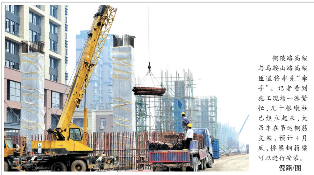
铜陵路高架与马鞍山路高架匝道将率先“牵手”。记者看到施工现场一派繁忙,几十根墩柱已经立起来,大吊车在吊运钢筋支架,预计4月底,桥梁钢箱梁可以进行安装。
