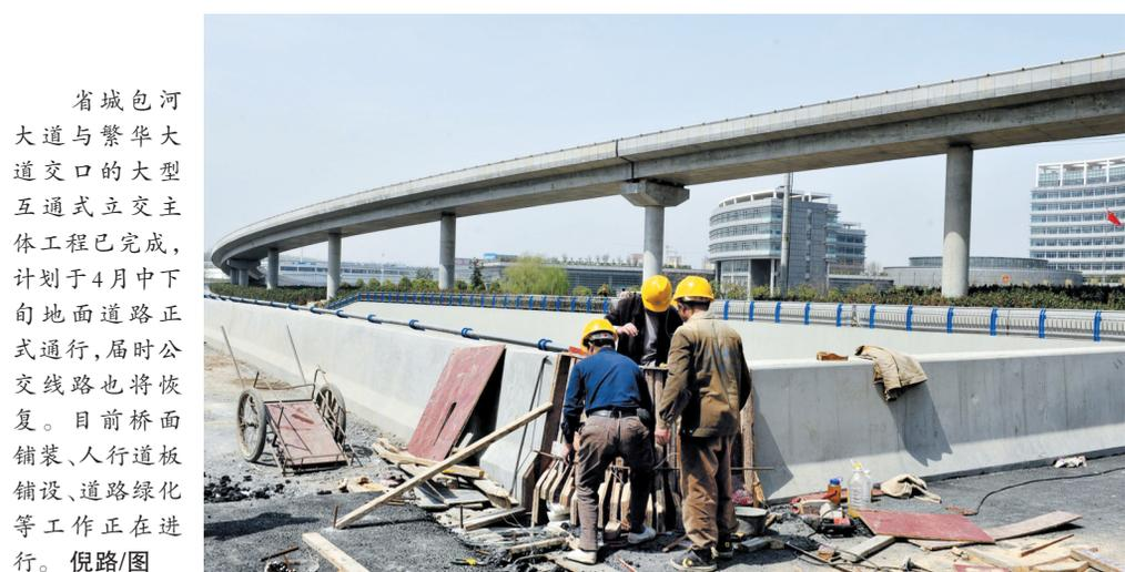
省城包河大道与繁华大道交口的大型互通式立交主体工程已完成,计划于4月中下旬地面道路正式通行,届时公交线路也将恢复。目前桥面铺装、人行道板铺设、道路绿化等工作正在进行。倪路/图
