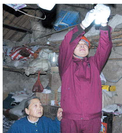
谷永武为老人安装节能灯
