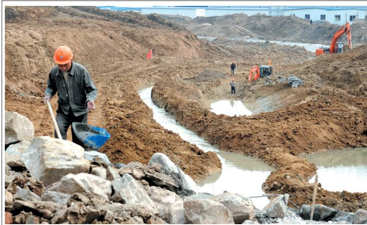
近日,二十埠河上游综合治理改造工程紧张施工。现场大型挖掘机在清理河道淤泥,周边施工人员在维护原有河堤。在基础治理工程结束后,二十埠河河岸将被打造成森林式的绿化景观。
