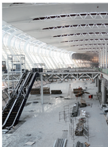
自动扶梯安装完毕
