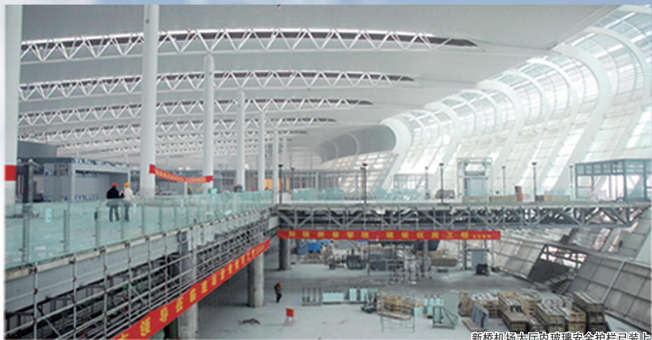
新桥机场大厅内玻璃安全护栏已装上
