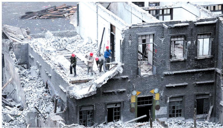
蒋介石“重庆行营”正在被拆除
