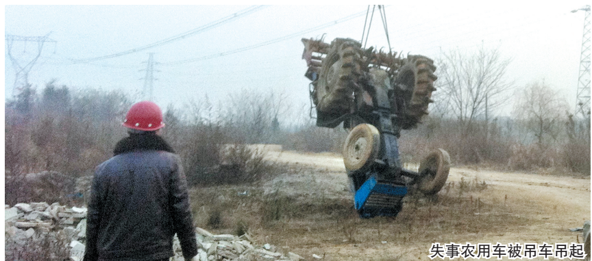
失事农用车被吊车吊起
