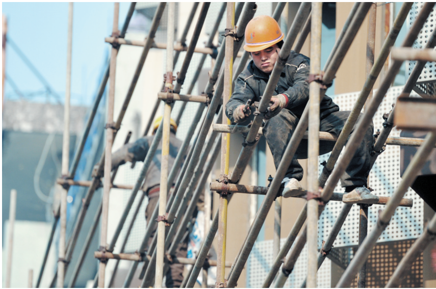
昨日,省城街头,几名未做防护措施的工人在半空中进行施工作业,过往路人见状都捏了一把汗。眼下临近年关,市民在工作、生活中都应注意安全,切莫松懈。
