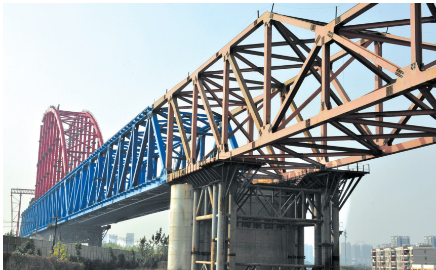
目前,合肥南环高铁重点控制工程——经开区特大桥已拼装过半,预计明年钢梁主体完工。该桥跨越合宁高速,连接沪汉蓉快速铁路,为下承式、等高度、连续、钢桁梁柔性拱桥,双线铁路,全长461米,其主跨度在同类型桥梁中居于首位。 倪路/摄
