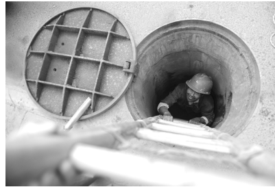
为保障秋季市政下水管道正常使用及道路安全,近日工作人员对省城马鞍山路地下管道进行维护修补工作。维护路段从马鞍山路与九华山路交叉口至马鞍山路与太湖路交口,预计工程两日内可以完成。 记者 黄洋洋/图
