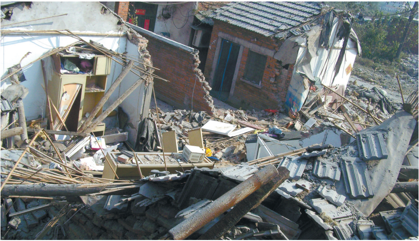
蒸压釜穿过 房屋成废墟
