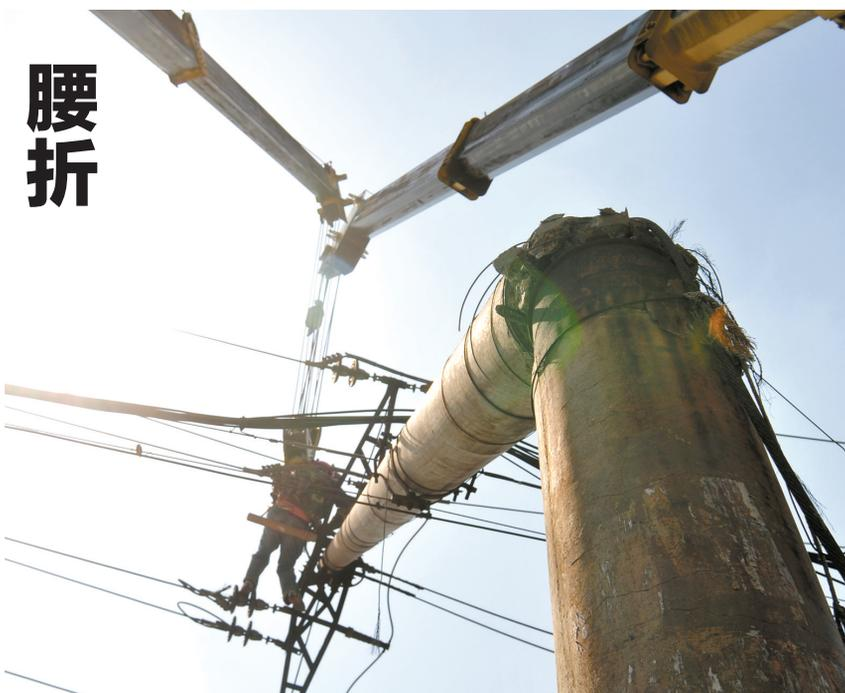
昨日凌晨,省城临泉东路北侧海洲景秀世家小区门口处,一根万伏电线杆遭“腰斩”。截至昨晚六点四十分,电力部门仍在抢修中,而附近上万居民只能“摸黑”。据电力公司一位工作人员介绍,初步推断电线杆折断时间为昨日凌晨。至于折断的原因,工作人员表示,可能是夜间行驶的大型货车挂到电线导致。截至昨晚六时四十分,电力抢修部门仍在紧张维修中。 记者 丁林/文 黄洋洋/图
