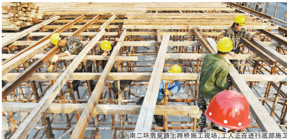
南二环翡翠路上跨桥施工现场,工人正在进行底部施工
