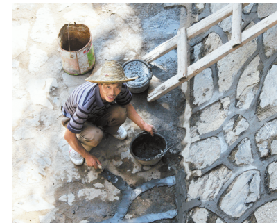
日前,记者在刚刚通车不久的嘉山路桥下看到,工人在对河堤地面进行粉刷养护。由于嘉山路桥建桥施工,该段部分河堤一直未进行有效养护。近日相关部门对河堤进行重新铺设粉刷,预计整个施工可在3天内完成。 记者 黄洋洋/图
