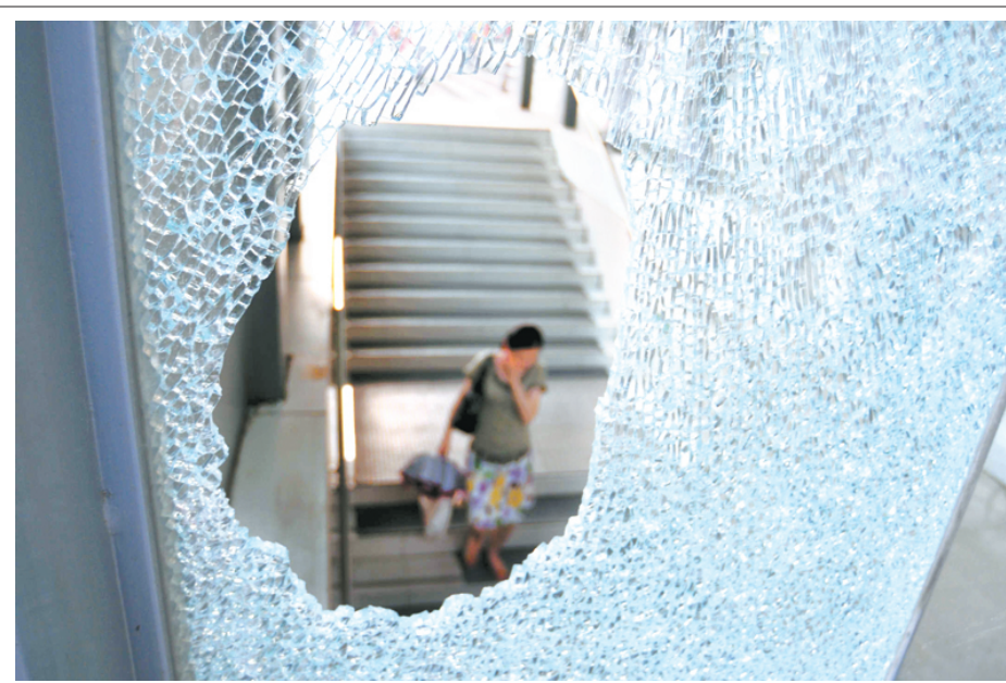
近日，记者通过省城飞凤街人行过街通道时看到，其北侧下穿口的玻璃墙遭到人为破坏，墙面破了一个大洞，整个玻璃墙体看起来随时可能会碎，影响了过往行人的安全，希望有关部门尽快维修。 记者 黄洋洋/图
