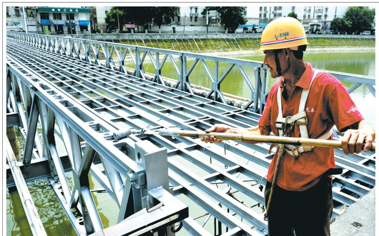
为期45天的合肥南淝河交通厅桥维修现场,施工人员在为桥体进行防腐处理。据悉,交通厅桥全长61米,宽4米,工程造价113.4万元,此次维修主要是桥面改造、主体结构加固、道板铺装,8月25日通行。 倪路 文/图
