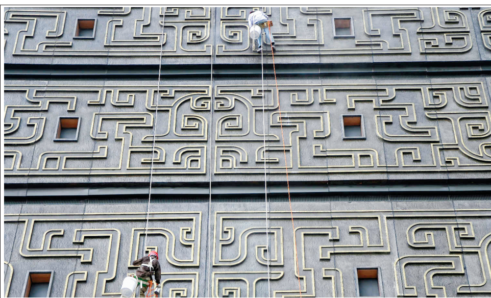
昨日,安徽省博物馆新馆外墙上,工人正在对墙面进行最后的喷涂处理。据悉,新馆整个墙立面采用了具有厚重历史感的仿青铜装饰材料,此次喷涂的材料不仅能反光,而且有防雨的效果。
