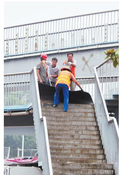
昨日下午,工人在对位于徽州大道与芜湖路交口的电信人行天桥部分桥面进行施工,拆除原有的防滑脚垫,为后期减震改造做准备。据悉减震改造工程预计可在9月之前结束。
