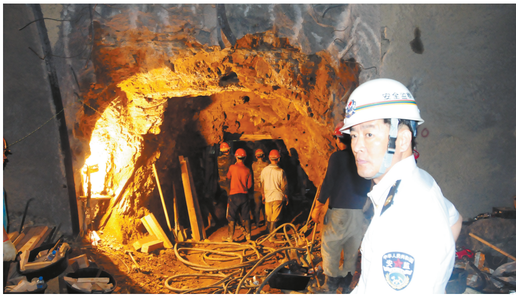
救援人员正在挖掘救援通道
