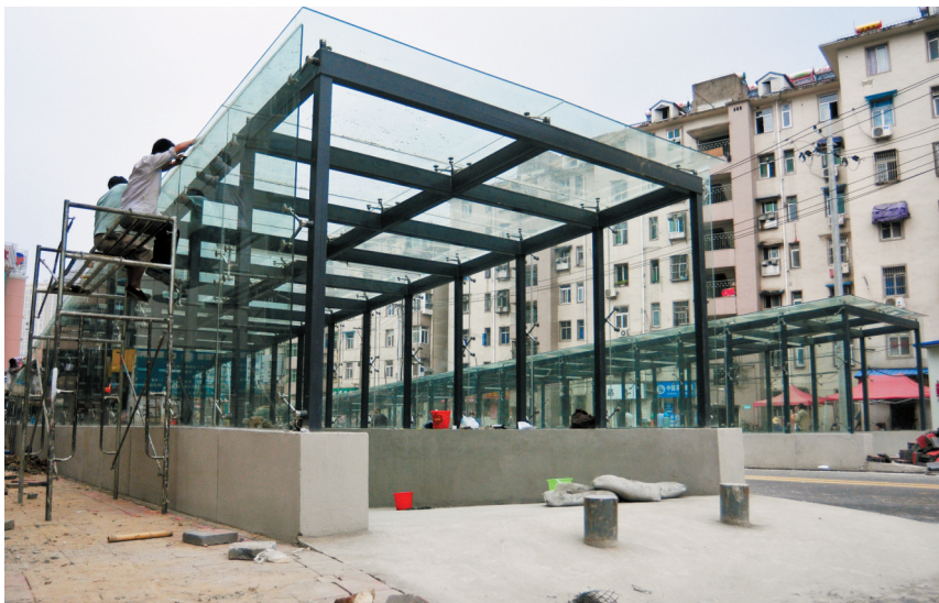
昨日,记者从合肥市渭河路下穿西一环工程现场获悉,目前该工程主体已经建成,如不受天气等特殊因素影响,本周有望全面放行交通。届时,由渭河路过往西一环的居民,将免受五里墩立交桥拦路挡道的困扰。
