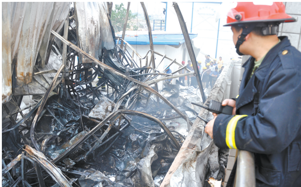
5月26日下午3点30分, 合肥市北二环与阜阳北路路口东铁路桥旁, 数十间工棚燃起熊熊大火。现场浓烟滚滚, 持续了近一个小时。据目击者称, 事发时有数名工人跑出工棚。火灾原因正在调查中。
