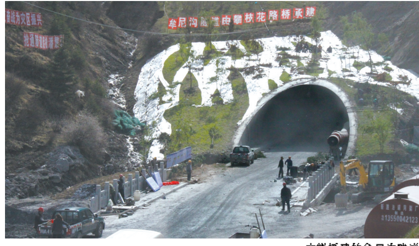
安徽援建的牟尼沟隧道
